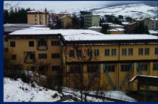
Retrofit con EPD di scuole a Potenza e prov., ex zona 1: D. Viola (2000) e G. Leopardi (2004)
