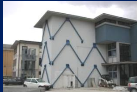
Retrofit con VED della scuola Gentile Fermi (danneggiata dal terremoto umbro-marchigiano del 1997-98) a Fabriano (Ancona), ex zona 2 (2000)
