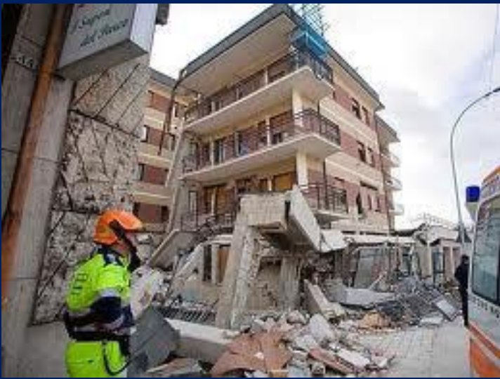
Collasso della Casa dello Studente all'Aquila (6/4/2009, M = 6,2)
