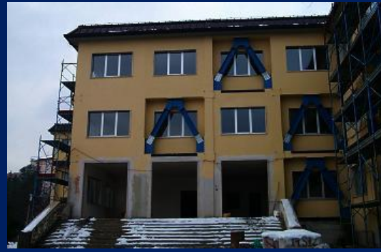
Retrofit con EPD di scuole a Potenza e prov., ex zona 1: D. Viola (2000) e G. Leopardi (2004)
