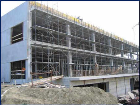
Costruzione della nuova Università Politecnica delle Marche (struttura prefabbricata in c.a.), Ancona, ex zona 2 (86 BRB, 2006)
