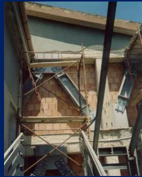
Retrofit con EPD di scuole a Potenza e prov., ex zona 1: D. Viola (2000) e G. Leopardi (2004)
