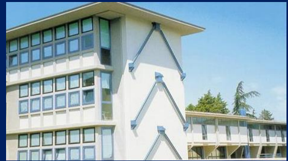
Retrofit con VED della scuola Gentile Fermi (danneggiata dal terremoto umbro-marchigiano del 1997-98) a Fabriano (Ancona), ex zona 2 (2000)
