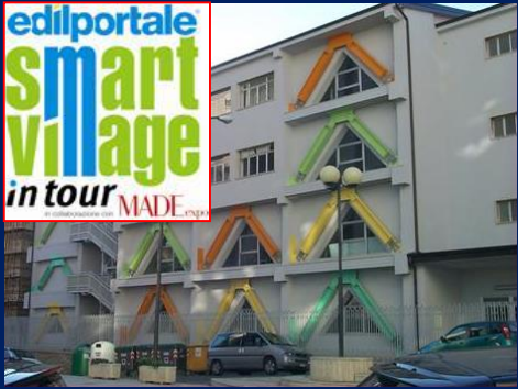
Retrofit con EPD di scuole a Potenza e prov., ex zona 1: D. Viola (2000) e G. Leopardi (2004)
