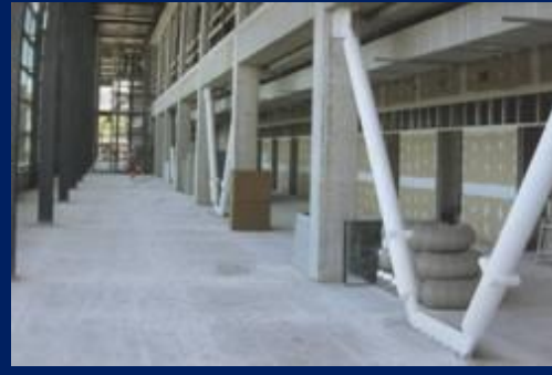
Costruzione della nuova Università Politecnica delle Marche (struttura prefabbricata in c.a.), Ancona, ex zona 2 (86 BRB, 2006)
